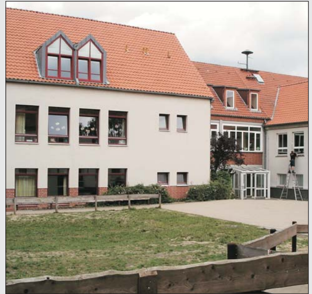
Südfassade der Grundschule Leiferde - der prallen Sonne ausgesetzt.
