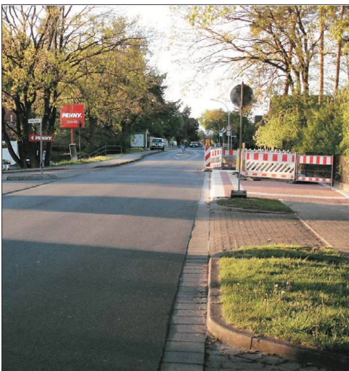
Die neue Haltestelle an zentralem Ort.
